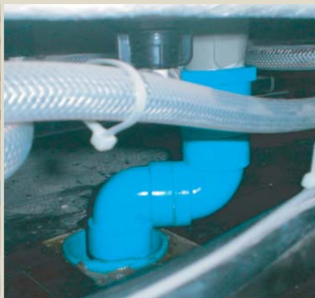
หลีกเลี่ยงการต่อก่อโดยไม่มีสารประสานทำให้แน่นหนา เช่น ตามภาพที่พื้นมีขนาดใหญ่ กว่าท่อมาตรฐาน 1 1/2 นิ้ว แต่ใช้วิธีการวางจุ่มลงไปเพียงเพื่อคาดว่ามันจะระบายได้ดี
