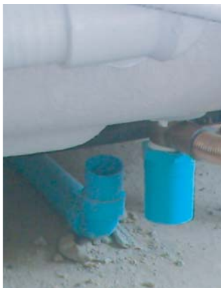
การติดตั้งก่อนน้ำถึงเป็นส่วนสำคัญ ต้องตรงตามตำแหน่ง หากไม่ตรง จำต้องแก้ไขเพื่อให้ได้ระยะ หรือหากมีระยะเพียงพอให้ต่อก่อตามภาพโดยพยายามให้มีทิศทางในการระบายน้ำได้ดีปกติ ไม่หักงอมาก
