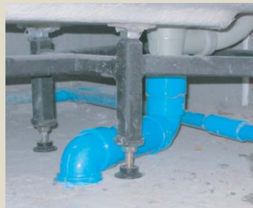
หลีกเลี่ยงการต่อก่อโดยไม่มีสารประสานทำให้แน่นหนา เช่น ตามภาพที่พื้นมีขนาดใหญ่ กว่าท่อมาตรฐาน 1 1/2 นิ้ว แต่ใช้วิธีการวางจุ่มลงไปเพียงเพื่อคาดว่ามันจะระบายได้ดี
