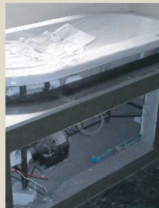
อุปกรณ์ประกอบอ่างอาบน้ำเช่น ชุดเบม ชุดเสด็จ หรือชุดระบายน้ำทิ้งของอ่างอาบน้ำ หากมีปัญหาใด ๆ อาจจำเป็นต้องถอดหรืออุปกรณ์เพื่อเปลี่ยนอุปกรณ์ดังกล่าว ซึ่งเป็นส่วนหนึ่งที่ผู้ใช้ควรรับทราบถึงการออกแบบพื้นที่ให้เหมาะสมหรือการต้องทาบหรือ ส่วนอื่น ๆ การทำช่อง Service ที่มีช่องระบายอากาศ เพื่อสามารถเข้าทำการตรวจสอบ ซ่อม หรือเปลี่ยนอุปกรณ์ต่าง ๆ ได้อย่างเหมาะสม รวมถึงระบายความชื้นต่าง ๆ เพื่อให้ อุปกรณ์ใช้งานได้อย่างเหมาะสม โดยเฉพาะอ่างระบบซึ่งลูกค้าต้องควบคุมให้มีการต่อระบบ ไฟฟ้ามีสายดินที่ถูกต้องตามมาตรฐาน
