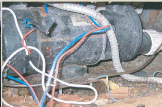
อุปกรณ์ประกอบอ่างอาบน้ำเช่น ชุดเบม ชุดเสด็จ หรือชุดระบายน้ำทิ้งของอ่างอาบน้ำ หากมีปัญหาใด ๆ อาจจำเป็นต้องถอดหรืออุปกรณ์เพื่อเปลี่ยนอุปกรณ์ดังกล่าว ซึ่งเป็นส่วนหนึ่งที่ผู้ใช้ควรรับทราบถึงการออกแบบพื้นที่ให้เหมาะสมหรือการต้องทาบหรือ ส่วนอื่น ๆ การทำช่อง Service ที่มีช่องระบายอากาศ เพื่อสามารถเข้าทำการตรวจสอบ ซ่อม หรือเปลี่ยนอุปกรณ์ต่าง ๆ ได้อย่างเหมาะสม รวมถึงระบายความชื้นต่าง ๆ เพื่อให้ อุปกรณ์ใช้งานได้อย่างเหมาะสม โดยเฉพาะอ่างระบบซึ่งลูกค้าต้องควบคุมให้มีการต่อระบบ ไฟฟ้ามีสายดินที่ถูกต้องตามมาตรฐาน
