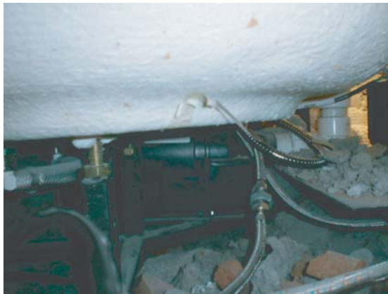
ใต้อ่างถึงแม้จะไม่เห็นหลังการติดตั้งแต่ต้องสะอาด เพื่อป้องกันปัญหาต่าง ๆ ที่อาจเกิดขึ้น
