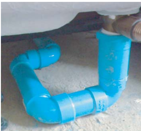
การติดตั้งก่อนน้ำถึงเป็นส่วนสำคัญ ต้องตรงตามตำแหน่ง หากไม่ตรง จำต้องแก้ไขเพื่อให้ได้ระยะ หรือหากมีระยะเพียงพอให้ต่อก่อตามภาพโดยพยายามให้มีทิศทางในการระบายน้ำได้ดีปกติ ไม่หักงอมาก
