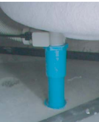
การติดตั้งก่อนน้ำถึงเป็นส่วนสำคัญ ต้องตรงตามตำแหน่ง หากไม่ตรง จำต้องแก้ไขเพื่อให้ได้ระยะ หรือหากมีระยะเพียงพอให้ต่อก่อตามภาพโดยพยายามให้มีทิศทางในการระบายน้ำได้ดีปกติ ไม่หักงอมาก
